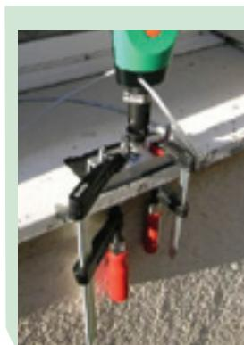
Befestigung mit Schraubzwinge
